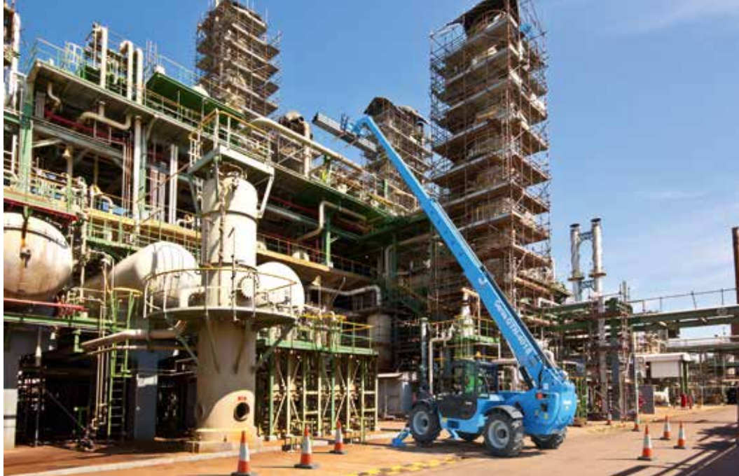
Der neue GTH-4018 mit hoher Tragkraft und Reichweite im Einsatz.
